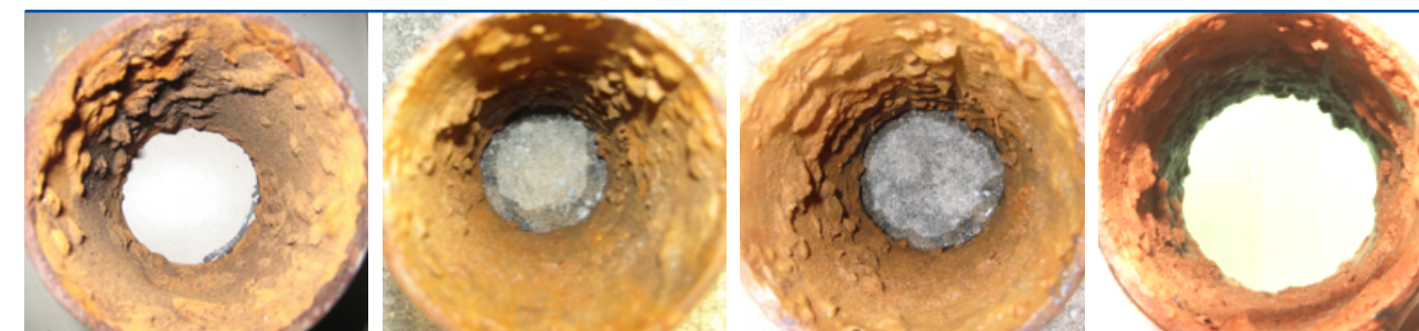
Avant l'installation (18 Août 2007)
