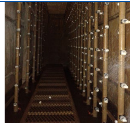
10% de la fonctionnalité de pulvérisation en raison des buses bloquées
