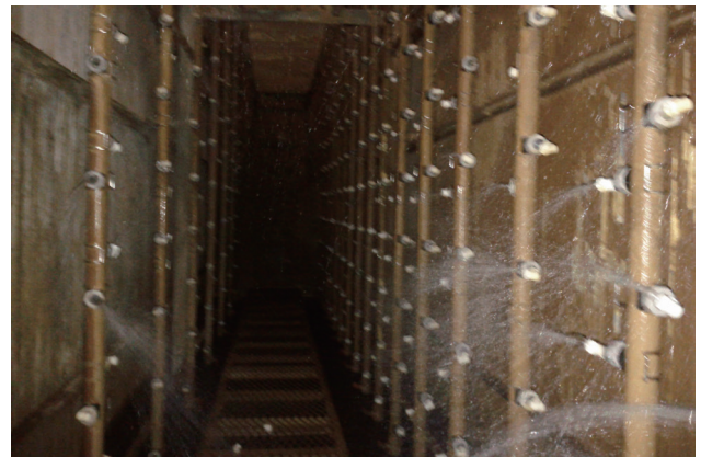
喷嘴几乎全部堵塞, 只有10%左右在喷雾
