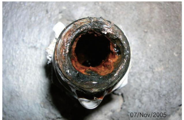
安装IOREX之后 安装了大约40天以后,可以确认到结垢明显减少。
